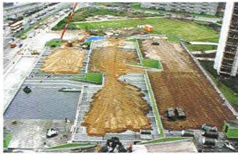
■ 7 – Null-Gefälle bei begrünem Schutz Aufbau mit dauerhaft leistungsfähigen Drainschichten und Feuchtigkeitsverteilungslagen
