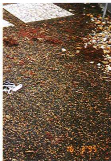
■ 11 – Beweissicherung im dritten Jahr mit Blähton-Schlackengemischsubstrat – Bewuchsdeckungsgrad < 10°
