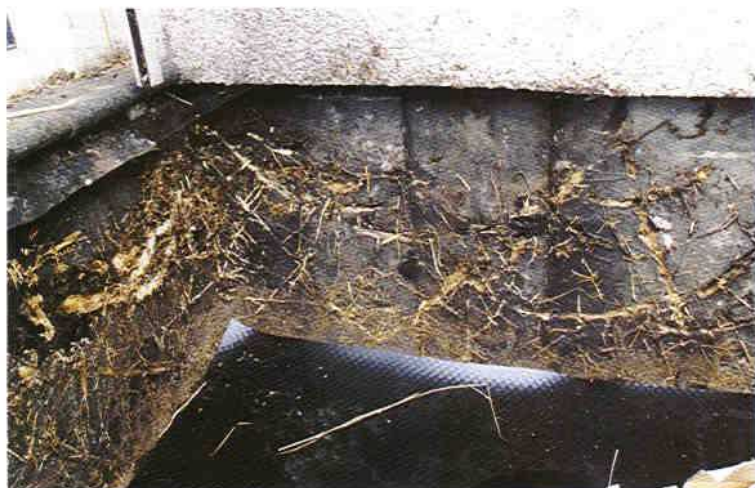
■ 11 – Beweissicherung im dritten Jahr mit Blähton-Schlackengemischsubstrat – Bewuchsdeckungsgrad < 10°
